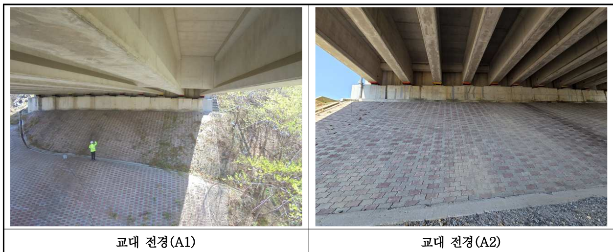
【사진 5.3.8】 교대 전경
