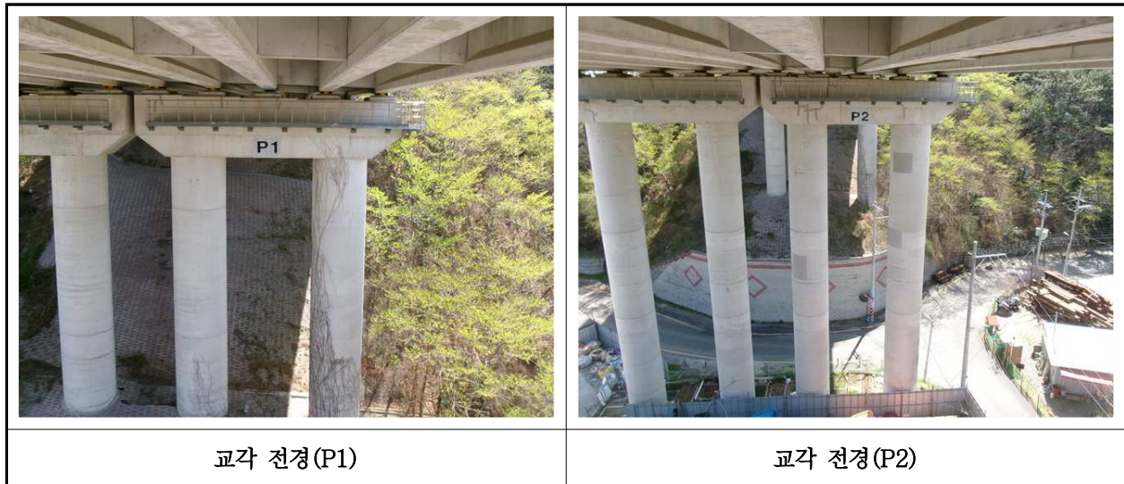
【사진 5.3.10】 교각 전경
