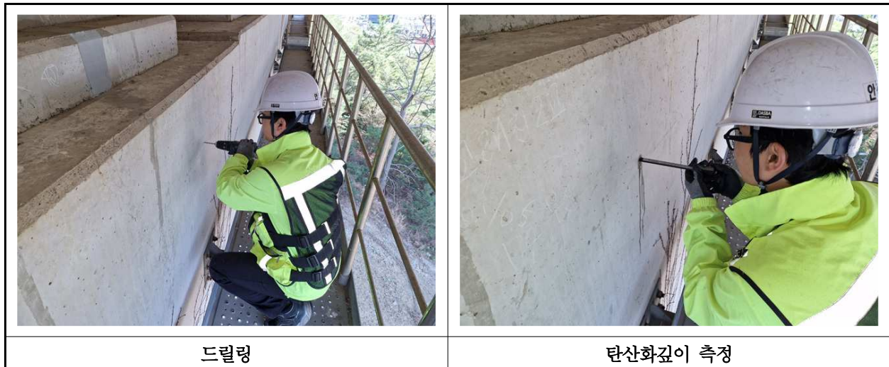
【사진 5.4.3】 탄산화 깊이 측정 현장사진
