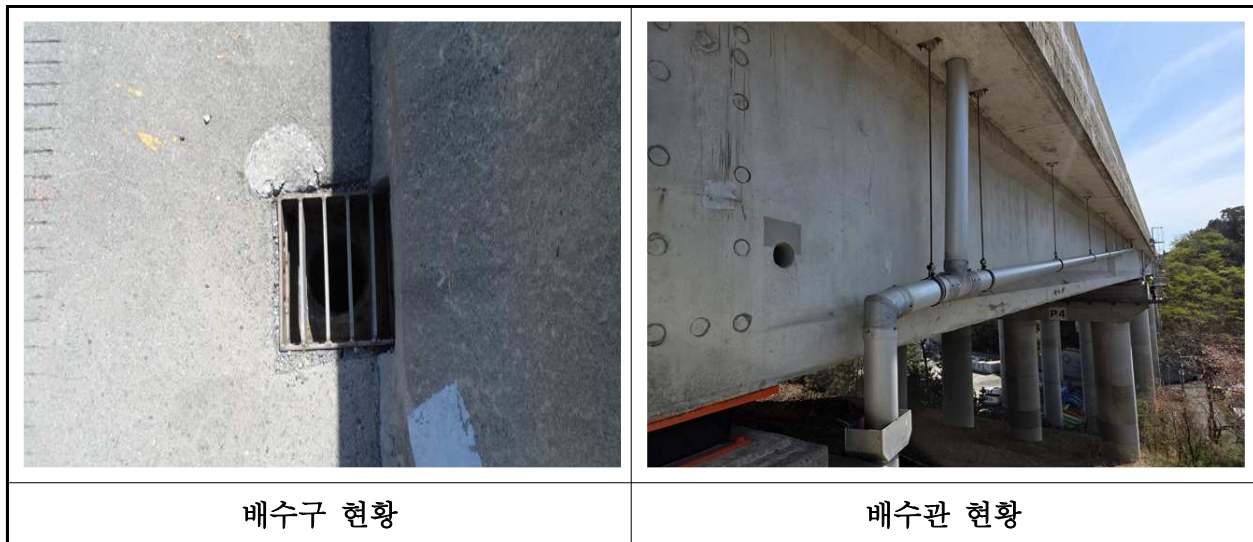
【사진 5.3.22】 배수시설 전경
