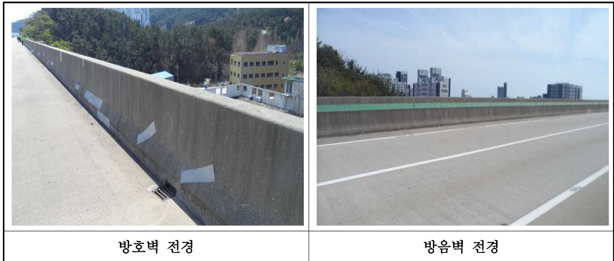
【사진 5.3.24】 방호벽 및 중분대 전경
