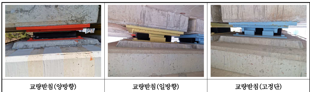
【사진 5.3.13】 교량받침 전경
